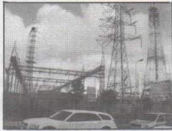
(2011年の橋本変電所)
