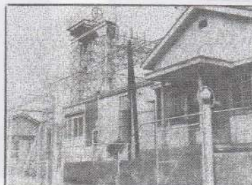
(南町内会の会合場所として 使われていた変電所の旧事務所)
